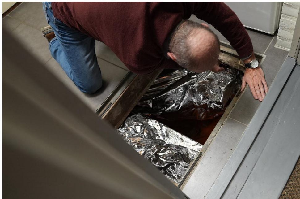
Tonzon (luchtkussen) vloerisolatie (4 e adres)
